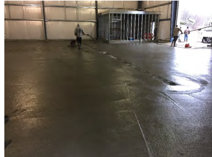
View of Concrete slab pour
