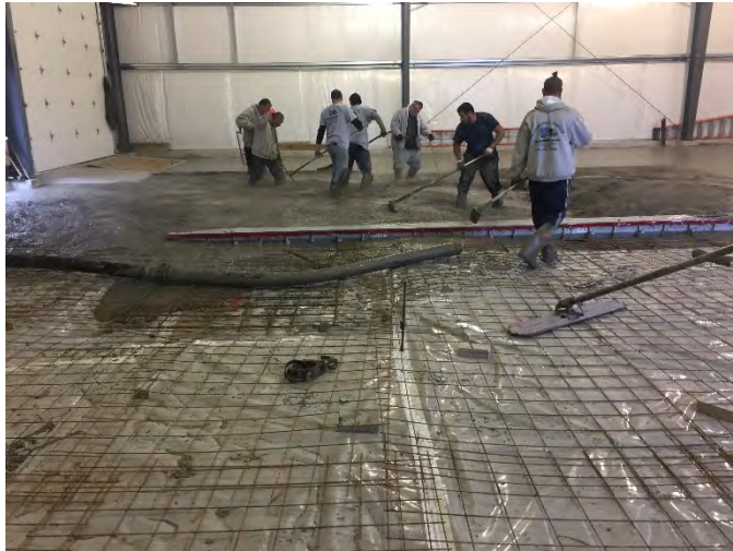
View of Concrete slab pour
