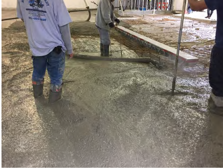
View of Concrete slab pour
